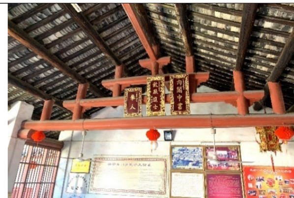
图32 兴宁东升围中堂构架
