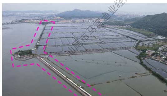
图 8-42 堤防岸线现状
