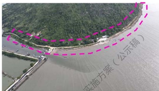
图 8-44 鸡笼山北侧基岩岸线现状
