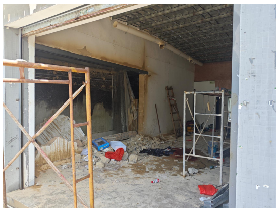
图 1：事故铺面施工现场照片
