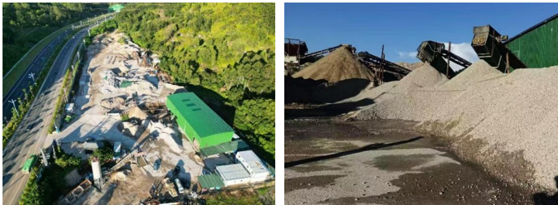
图 3-3 汕尾市城区东涌镇建筑垃圾再生利用项目现状图
