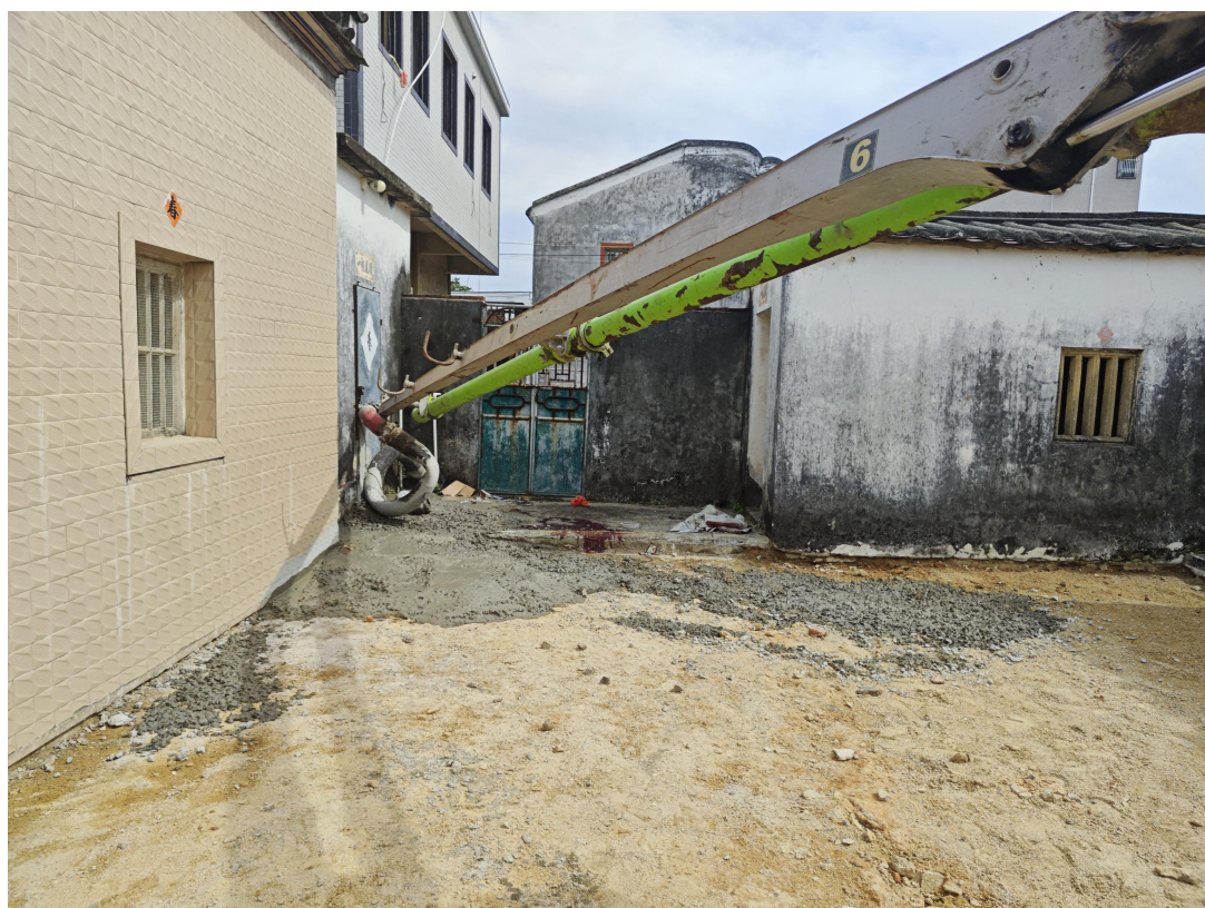
图 4：泵车输送臂末端碰撞位置照片
