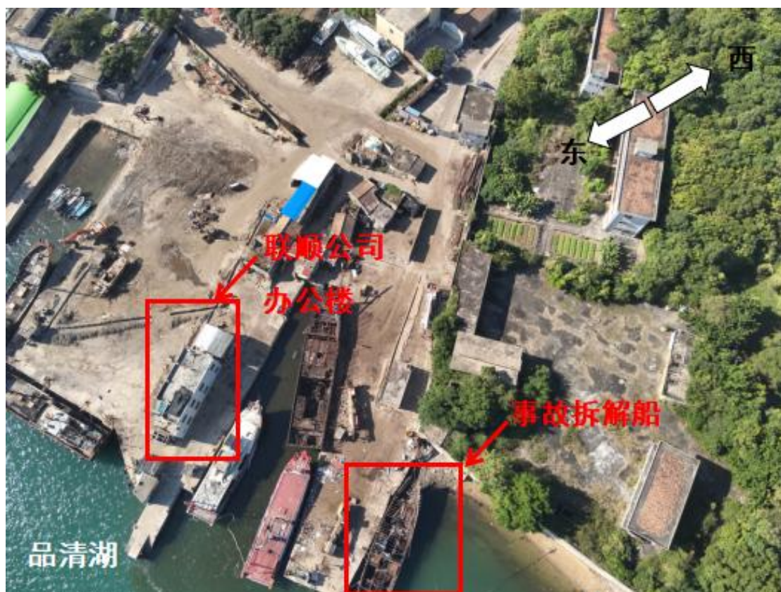
图 1 联顺公司拆船场地俯视图
