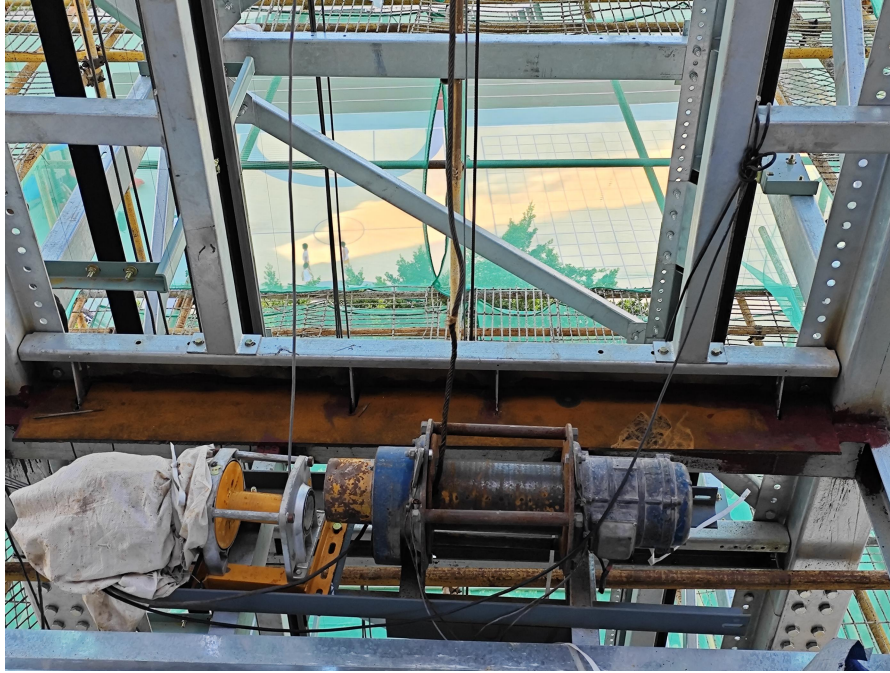
图 5 安装在七楼廊桥的卷扬机
